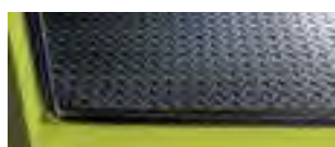
Suelo del contenedor con superficie de chapa metálica antideslizante
